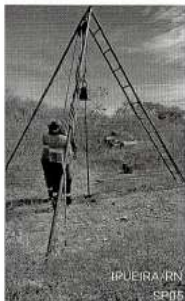
FIGURA 1: EXECUÇÃO DE SONDAGEM EM IPUEIRA/RN
