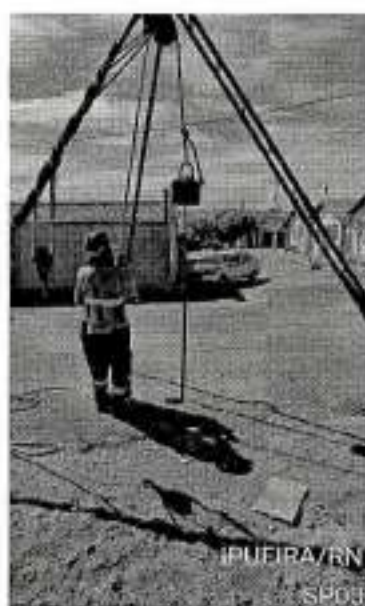
FIGURA 2: EXECUÇÃO DE SONDAGEM EM IPUEIRA/RN
