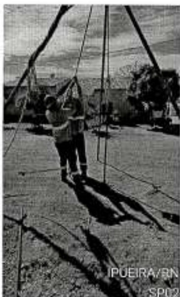
FIGURA 2: EXECUÇÃO DE SONDAGEM EM IPUEIRA/RN
