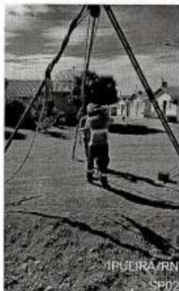
FIGURA 1: EXECUÇÃO DE SONDAGEM EM IPUEIRA/RN
