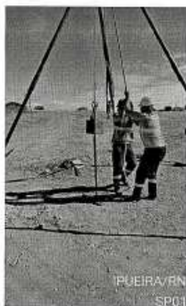
FIGURA 2: EXECUÇÃO DE SONDAGEM EM IPUEIRA/RN
