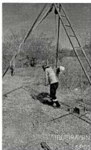
FIGURA 2: EXECUÇÃO DE SONDAGEM EM IPUEIRA/RN
