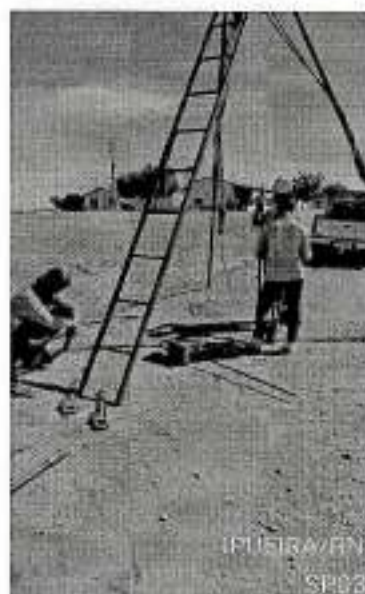
FIGURA 1: EXECUÇÃO DE SONDAGEM EM IPUEIRA/RN
